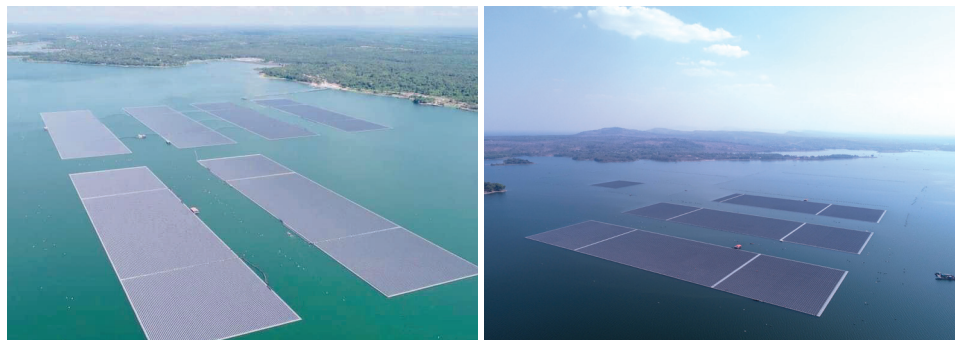
ระบบผลิตไฟฟ้าเซลล์แสงอาทิตย์บนทุ่นลอยร่วมกับโรงไฟฟ้าพลังน้ำ 45 เมกะวัตต์ (AC) ที่เขื่อนสิรินธร จ.อุบลราชธานี
