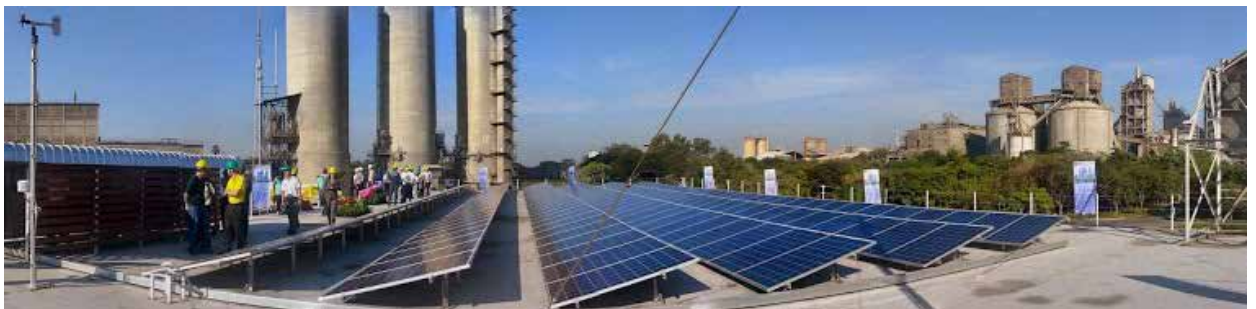
รูปที่ 2.5 : การผลิตไฟฟ้าพลังงานแสงอาทิตย์ติดตั้งบนดาดฟ้าอาคารสำนักงาน ขนาดกำลังการผลิต 49 กิโลวัตต์สูงสุด ที่อำเภอท่าลาน จังหวัดสระบุรี เป็นการผลิตไฟฟ้าเพื่อใช้งานภายในโรงงานมิได้ขายไฟฟ้า (ที่มา : บริษัท เอส ซี ไอ อีโค เซอร์วิสเชส จำกัด)
